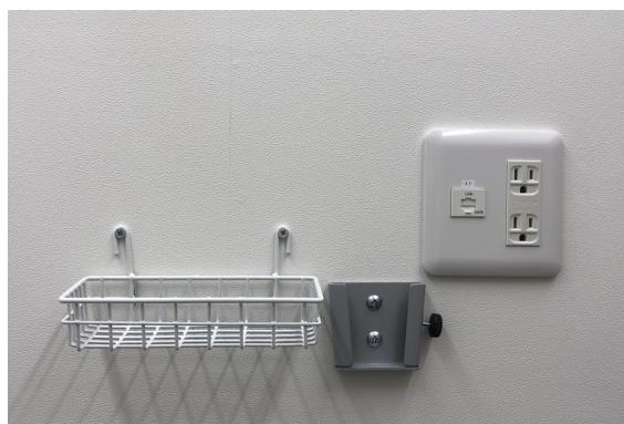
金具を打つべきところに先にコンセントをつけられてしまった例。止むを得ず左にずらしている。
